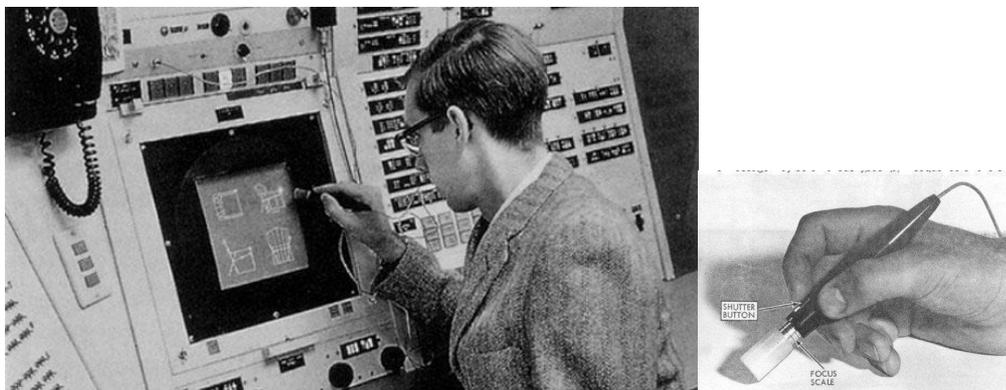
Figura 8 e 9 - Sketchpad. Figura 9 - Caneta óptica
